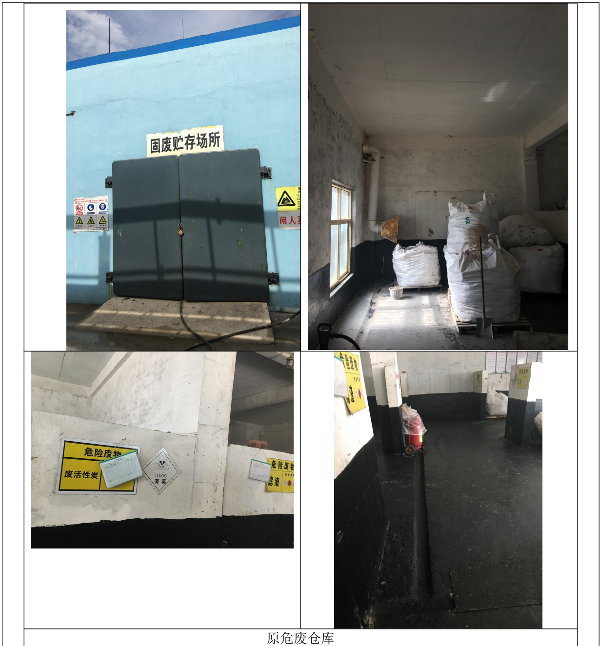
图 3-3 新建危废仓库及原危废仓库
